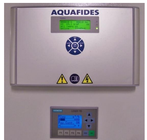
AQUAFIDES kontrollskap med effektregulering og display som skifter farge etter driftsstatus
